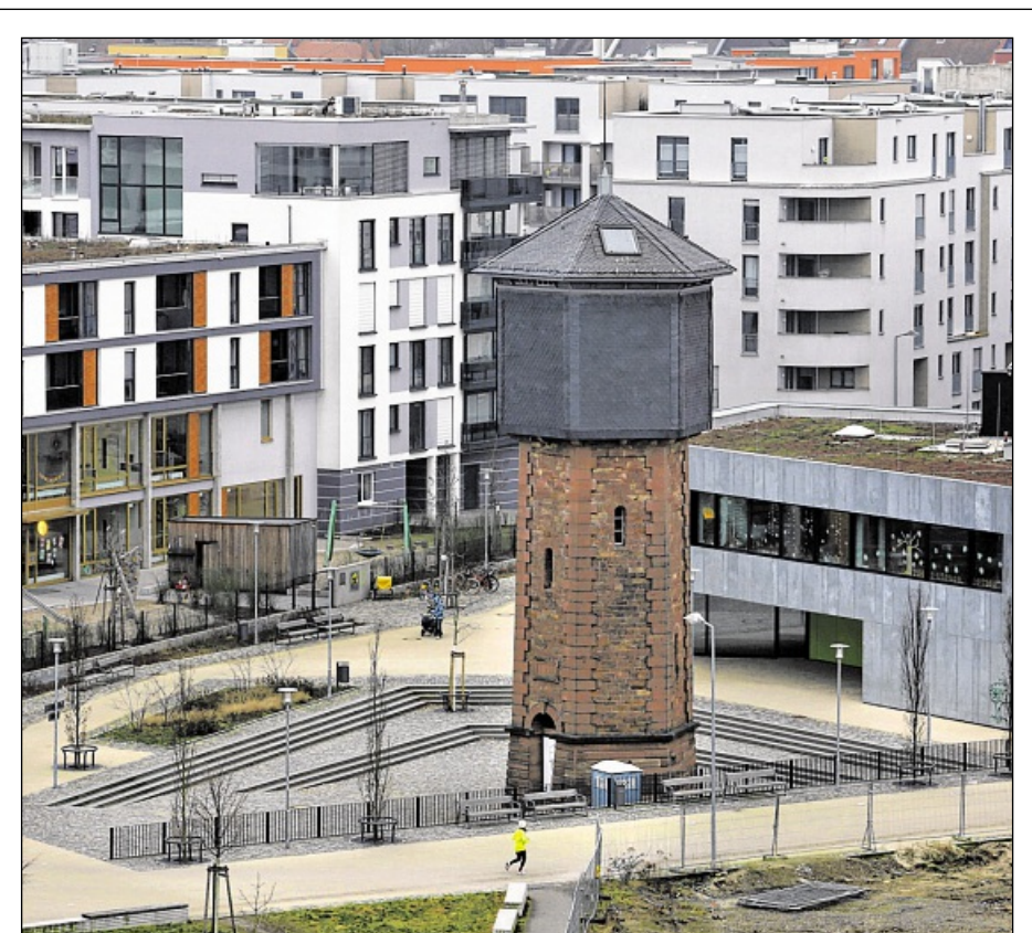
DER ALTE WASSERTURM im Neubaugebiet „Karlsruhe Südost“ ist bezugsfertig. Eine Hotelsuite mit Doppelbett hat man unterm Dach eingerichtet. Foto: jodo
